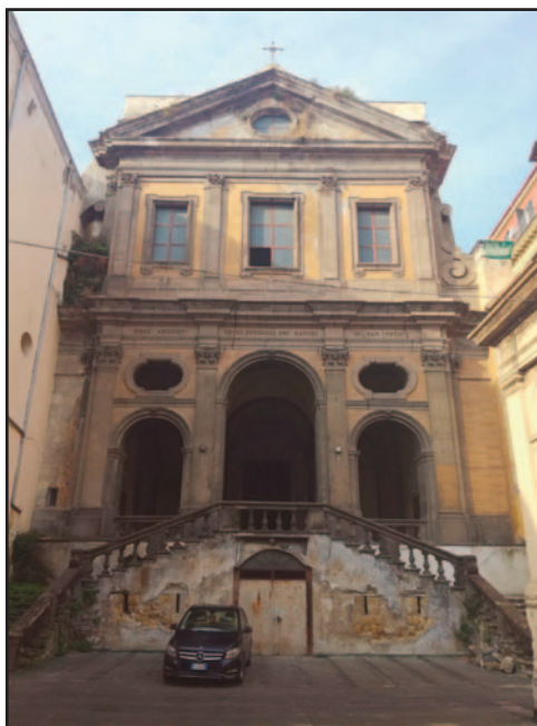
fig. 1 - San Potito (facciata)
