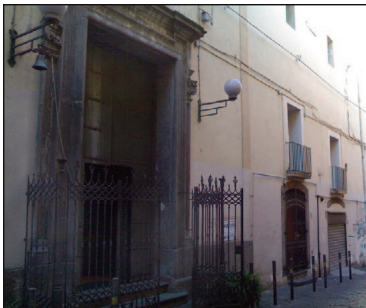
fig. 1 - Chiesa di Santa Monica (facciata)
