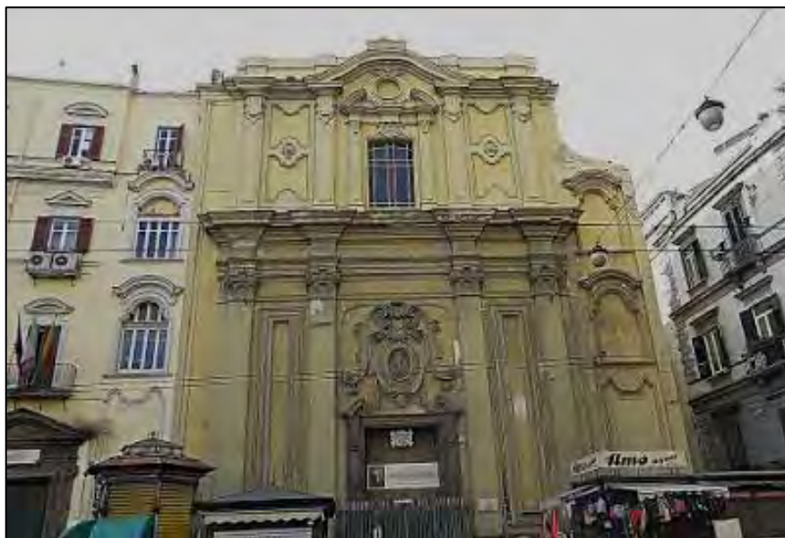
fig. 23 - Chiesa di S. Maria di Caravaggio, facciata
