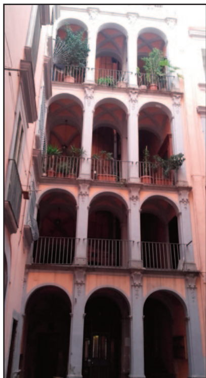
fig.14 Palazzo Loffredo scala interna
