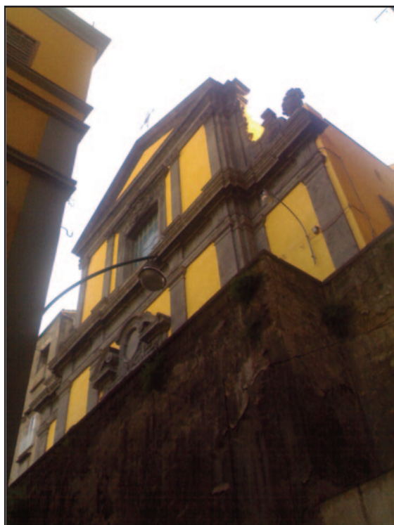
fig. 1 - Chiesa S. Agostino degli Scalzi (facciata)
