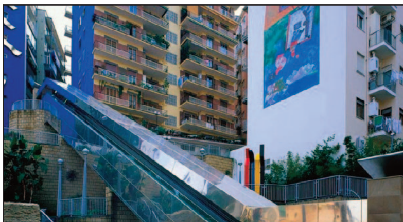
fig. 32 - Stazione Salvator Rosa della Metropolitana di Napoli
